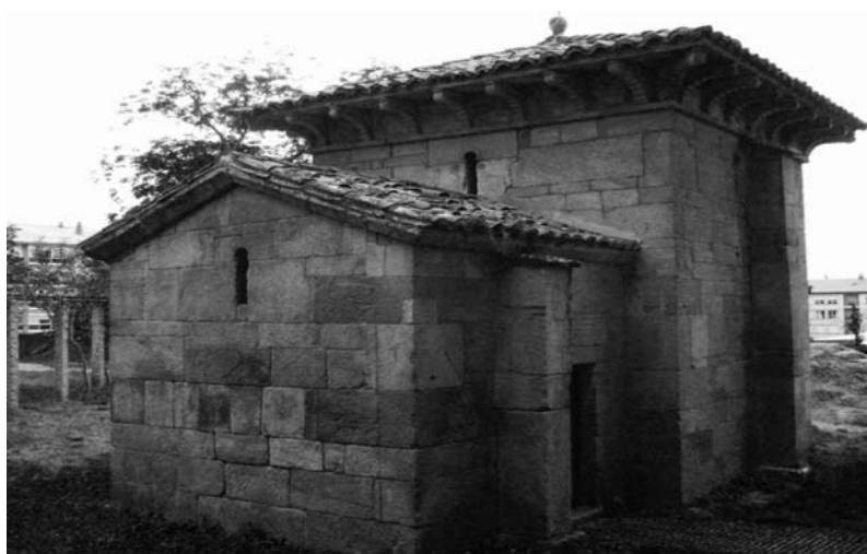
San Miguel de Celanova. Su cubierta central a cuatro aguas está coronada por un cipo o signáculo de cuerpo globuloso.
