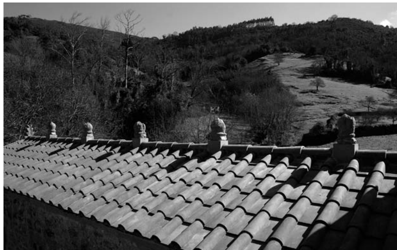
Cipos de la cubierta de la iglesia de San Salvador de Valdediós.
