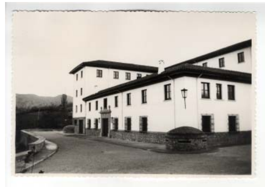
▪ Fig. 9. Casa cuartel de la Guardia Civil. AGA, caja F/04228-016-002.
